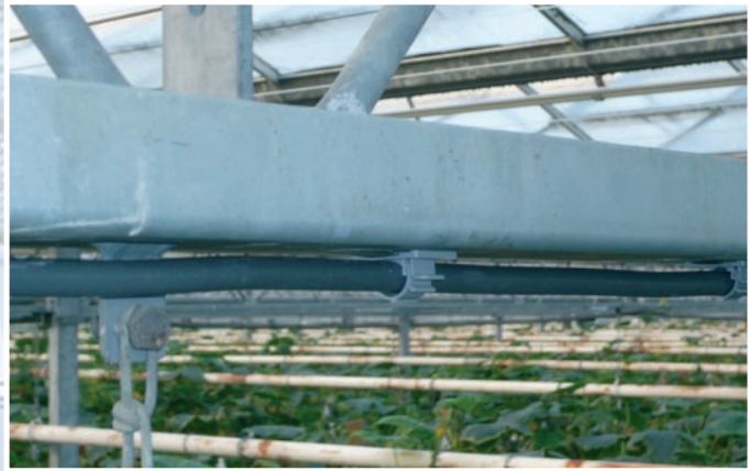
Clip voor snel en netjes bevestigen van kabels.
