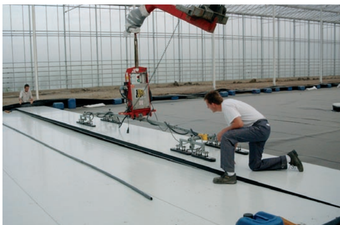
Het neerleggen van de vloer op het water.
