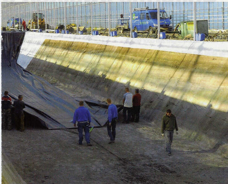
De opslagcapaciteit van een Klimrek Buffer is ongeveer vier kubieke meter per vierkante meter. Een bassin haalt beduidend minder kubieke meters per vierkante meter door de omliggende dijken. Foto: ErfGoed BV
